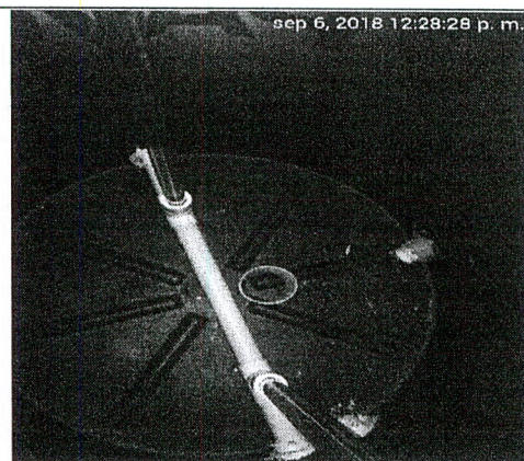
Foto No. 6 Sistema de tratamiento de ARnD.
